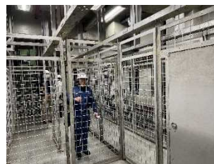
写真7 主訓練塔 地下2階(a)
