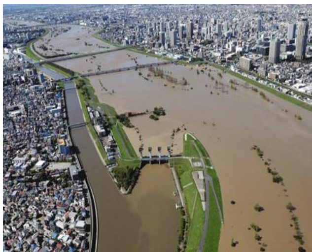
令和元年東日本台風に伴う増水した荒川
