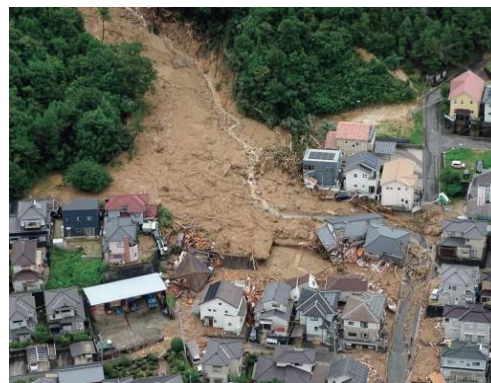
広島県安芸郡熊野町の土砂災害の状況
