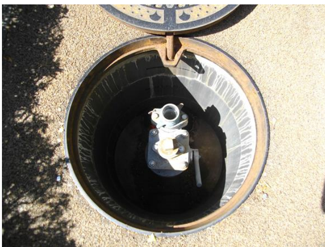
地下に埋設された消火栓の内部
