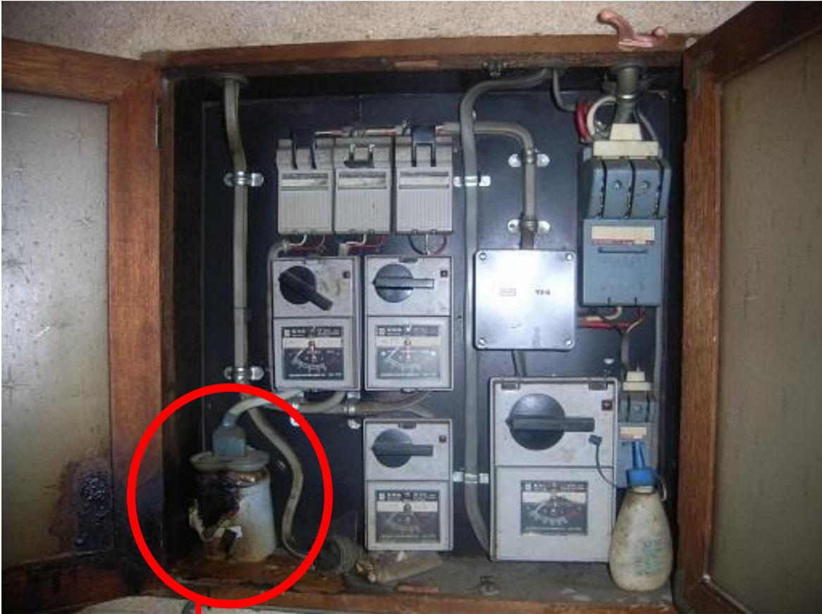
分電盤の低圧進相コンデンサ設置例
