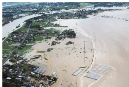
平成27年9月関 東・東北豪雨 での被災状況
