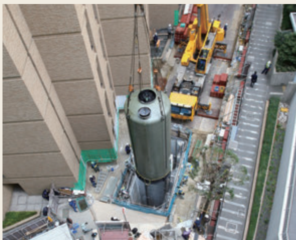
▲ 危険物タンクの設置時の状況
