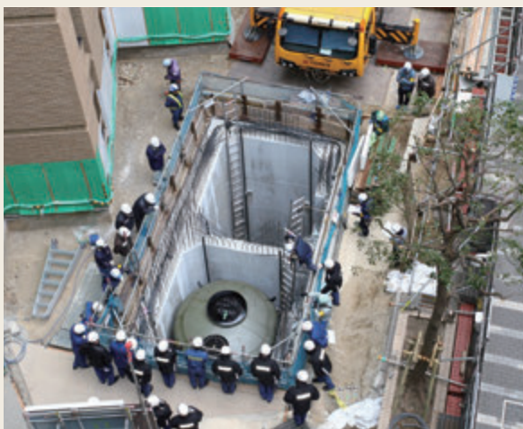
▲ 危険物タンクの設置時の状況
