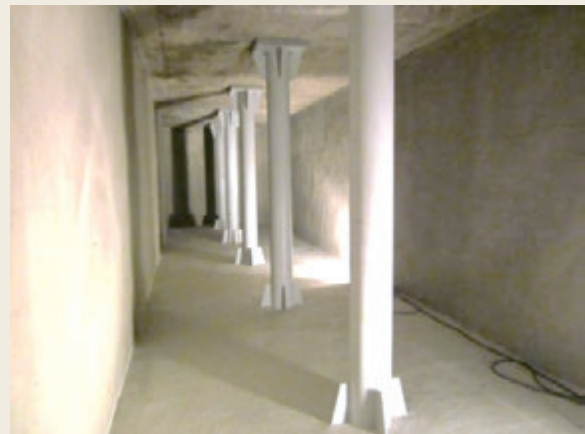
▲ 経年防火水槽の再生
