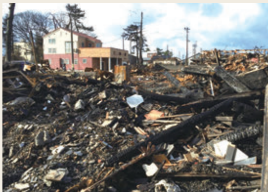
▲糸魚川市大規模火災の状況
