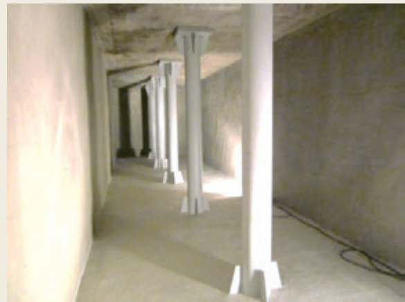
▲ 経年防火水槽の再生
