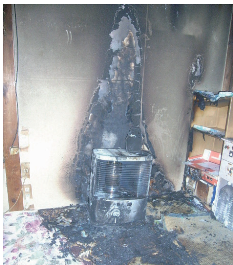
写真 2-8-1 石油ストーブの焼損状況
