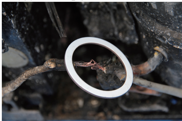
写真 2-6-4 電源コードの短絡の状況
