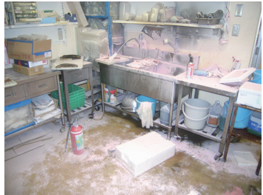
写真 3-3-3 出火した調理場の状況
