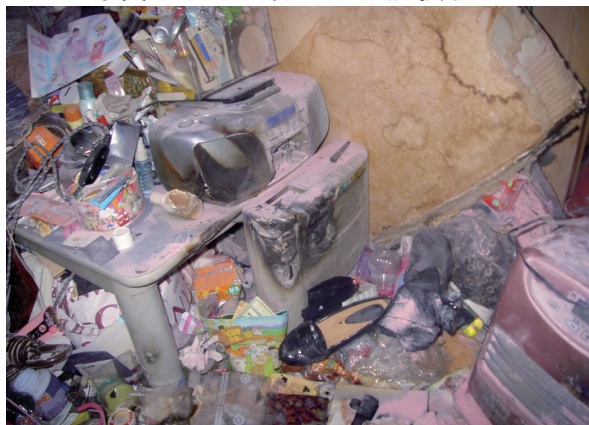
写真 3-3-2 居室内の焼損状況
