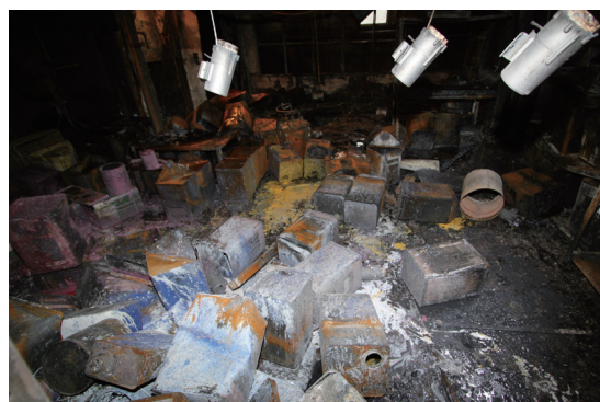
写真 3-2-1 工場内の状況
