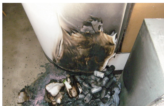
写真 6-9-2 焼損したごみ箱の状況
