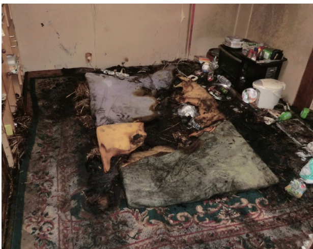
写真 2-2-3 出火室の布団とじゅうたんの焼損状況
