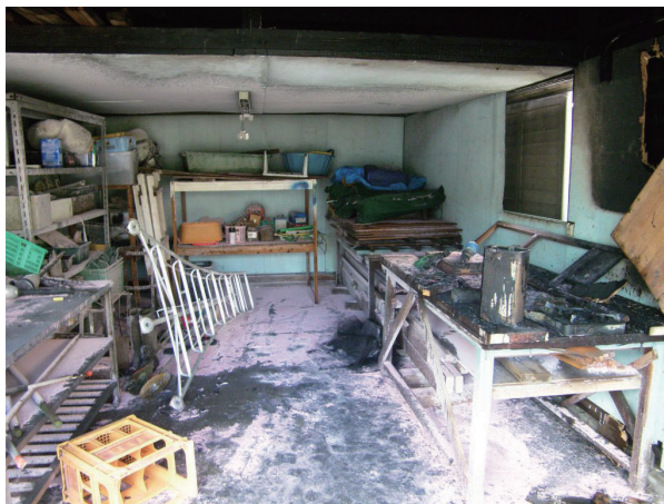
写真 2-7-3 倉庫内の状況
