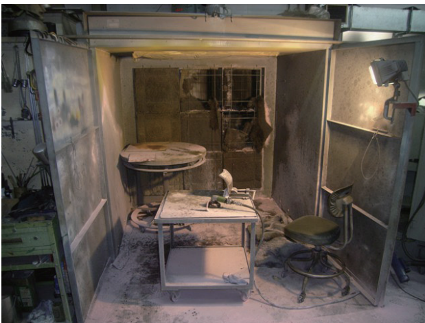
写真 6-7-3 塗装ブースの状況
