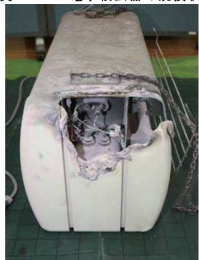
写真 3-5-5 電撃殺虫器の焼損状況
