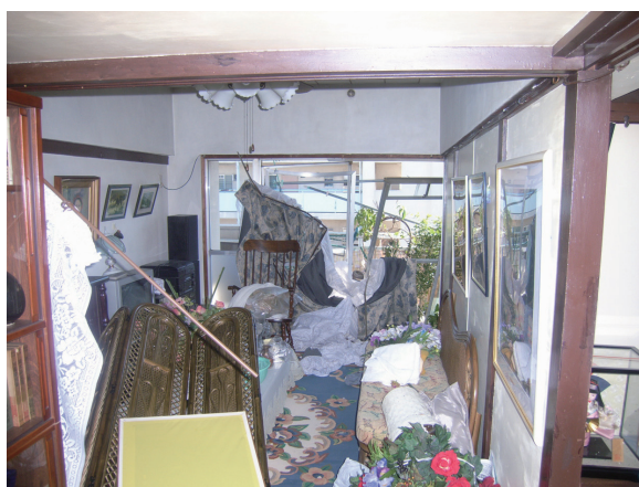
写真 3-4-1 居室内の状況
