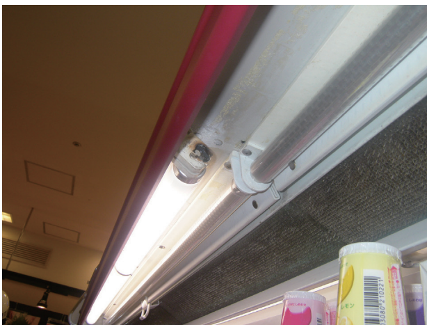
写真 6-3-3 冷蔵ショーケースの照明の状況
