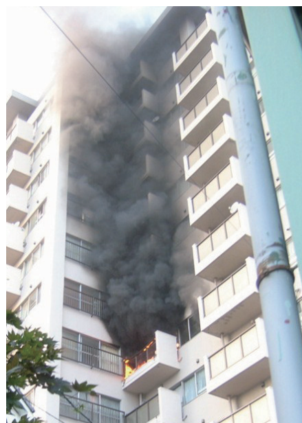
写真 8-1 消防隊到着時の状況
