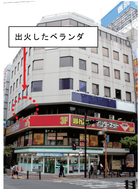
写真 8-3 出火建物の状況
