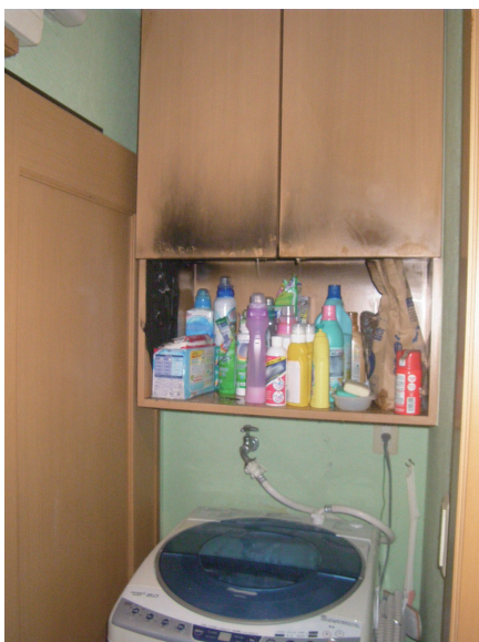
写真 2-4-1 吊戸棚の状況
