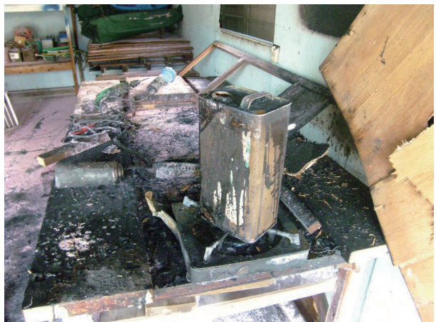
写真 2-7-4 ニス缶の焼損状況
