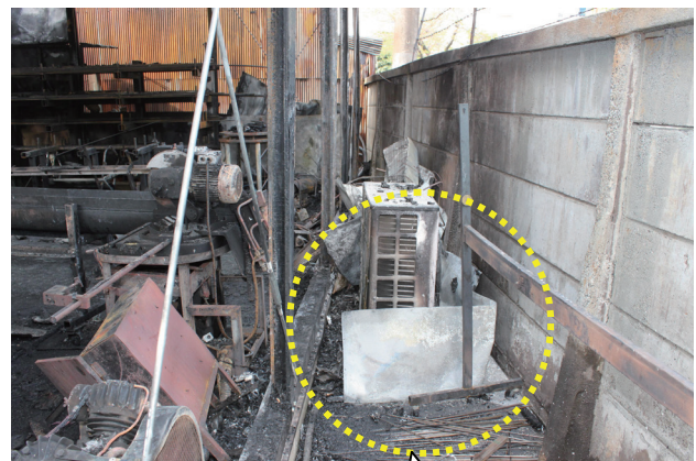
写真 2-1-5 出火箇所付近の状況
