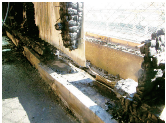
写真 2-8-4 建物内部の焼損状況
