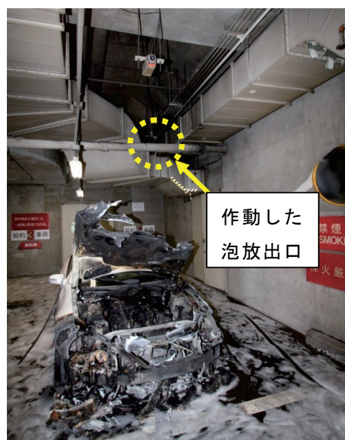
写真 7-1 出火箇所の状況
