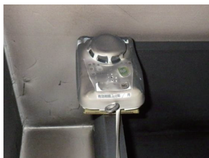
写真 3-1-3 警報器の状況
