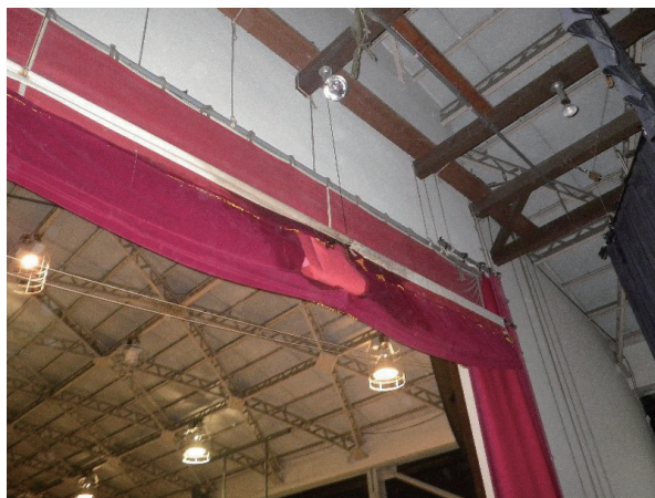
写真 6-6-1 緞帳とライトの状況（通常時）
