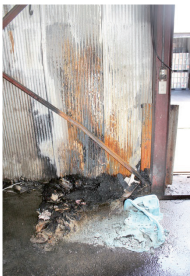
写真 6-8-1 倉庫内部の状況
