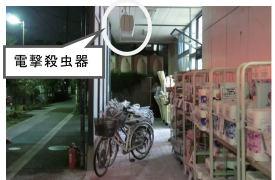
写真 3-5-3 出火箇所の状況
