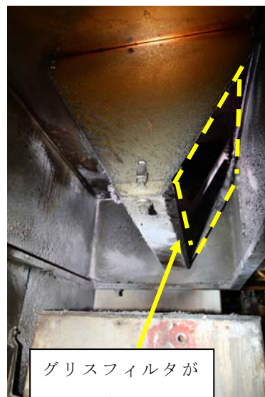
写真 6-2-2 天蓋内の状況
