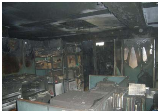
写真 6-9-1 事務室内の状況
