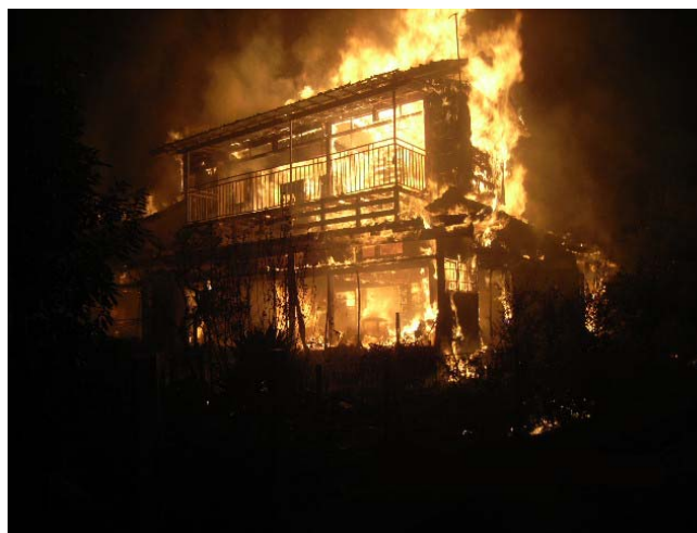
写真 6-1-4 出火建物の焼損状況
