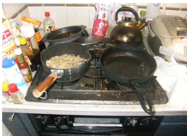
写真 3-1-1 ガステーブル付近の焼損状況
