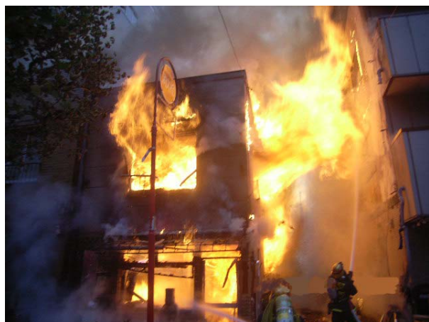
写真 8-1 隣棟への延焼状況
