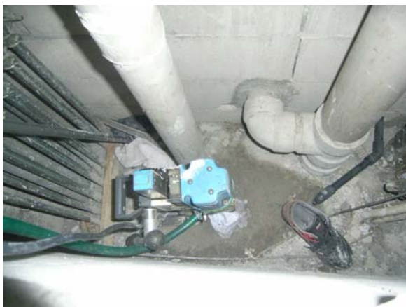
写真 3-4-1 パイプスペースの状況
