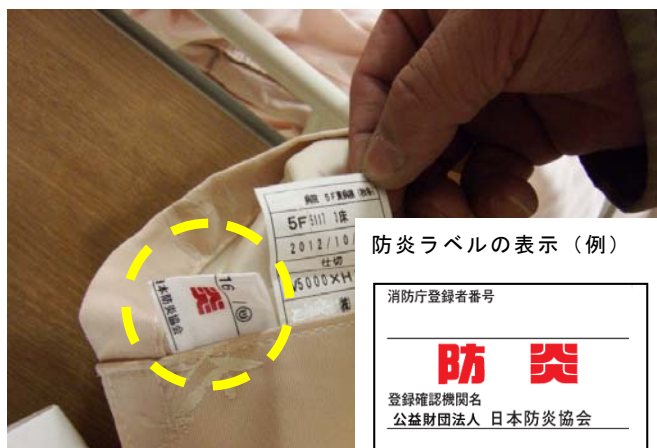
写真 6-10-4 防災カーテンのラベル表示
