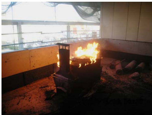
写真 2-8-1 溶解釜の延焼状況
