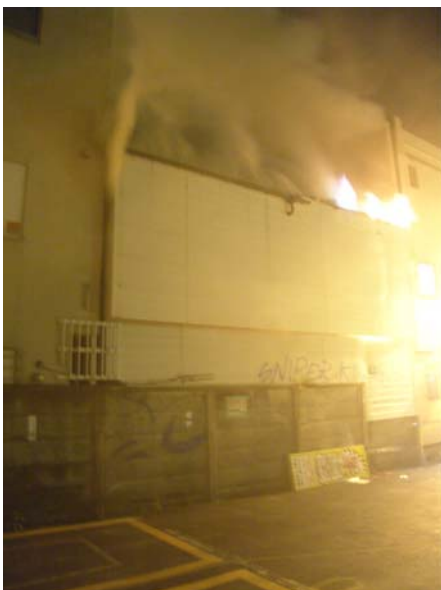
写真 2-2-1 消防隊到着時の延焼状況
