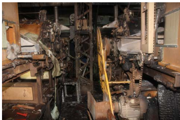
写真 6-7-3 作業場内の鉄骨支柱の状況
