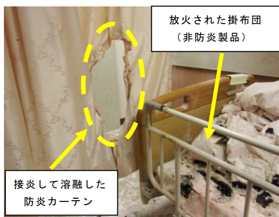
写真 6-10-3 病室内の焼損状況
