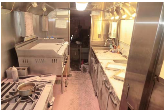
写真 6-13-3 キッチンカー内部の状況
