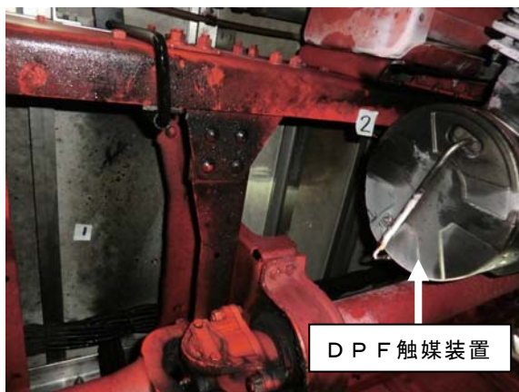
写真 6-12-2 D P F 触媒装置の焼損状況
