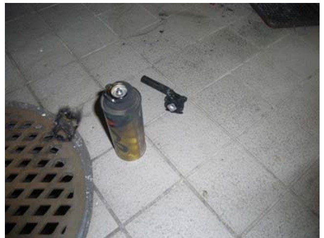
写真 3-3-3 焼損したバーナの状況
