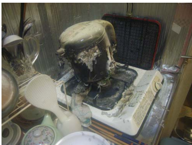
写真 5-1-3 電気ポットの焼損状況
