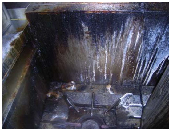
写真 6-2-5 寸胴鍋下の油かすの状況
