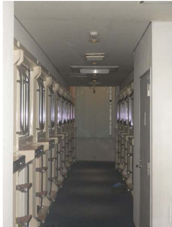
写真 6-4-3 出火階の状況
