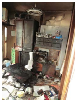
写真 6-1-7 住宅用火災警報器の設置状況
