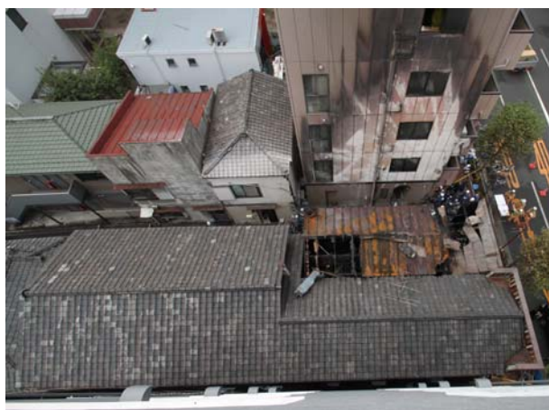
写真 8-2 類焼建物の焼損状況
