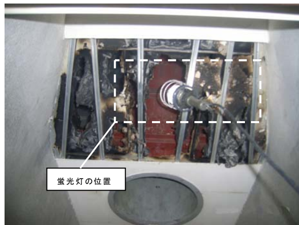
写真 6-4-1 リネンシューター外観の状況 写真 6-4-2 リネンシューター内部の焼損状況
