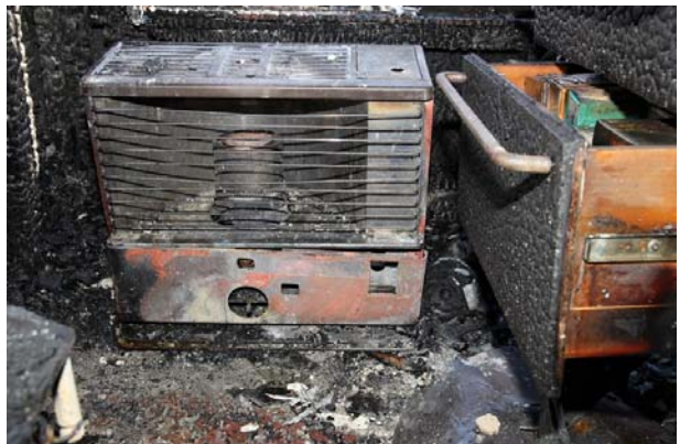
写真 5-1-4 石油ストーブの焼損状況
