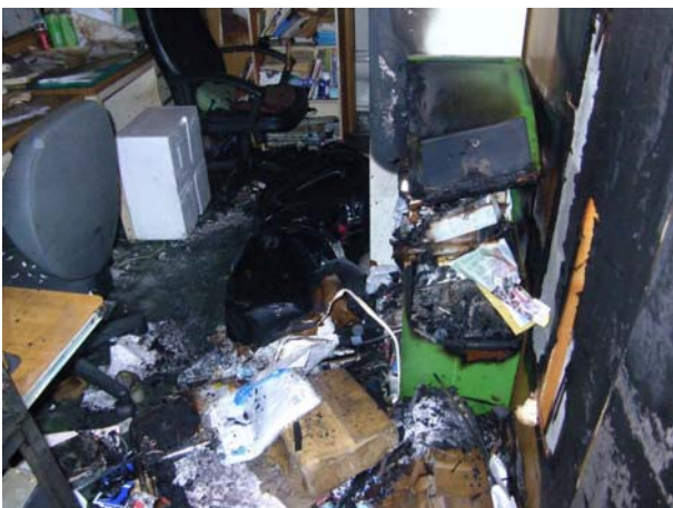
写真 6-9-4 事務室内の状況
