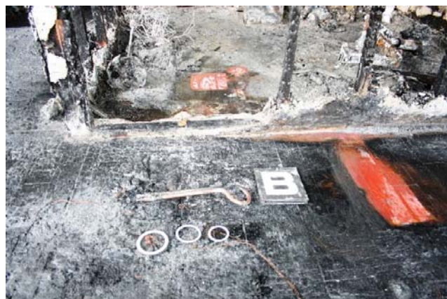
写真 5-2-2 投込湯沸器の状況
