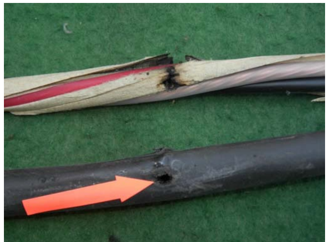
写真 5-2-4 引込線の貫通状況
