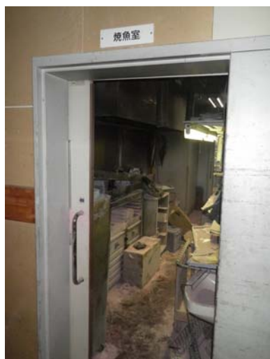
写真 8-3 倉庫（元魚焼室）付近の状況
