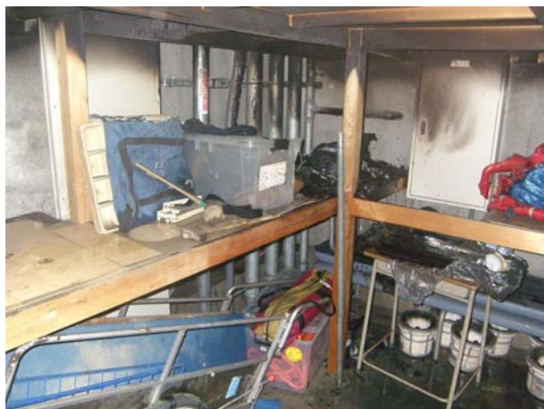
写真 6-6-1 倉庫内の状況
