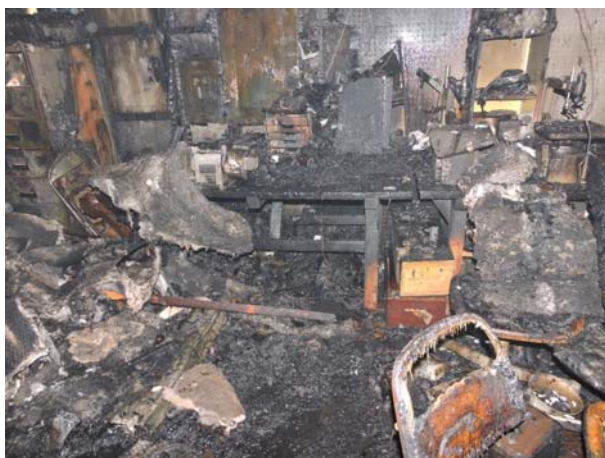
写真 6-8-1 出火箇所の状況
