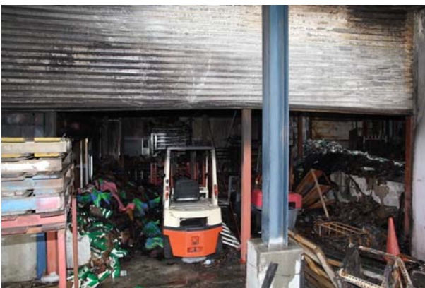
写真 6-8-3 資材倉庫内部の状況
