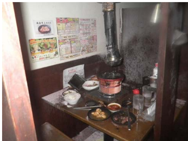
写真 8-1 焼損した上引きダクト
