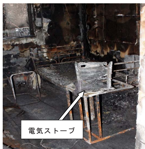
写真 6-1-2 出火室の復元状況
