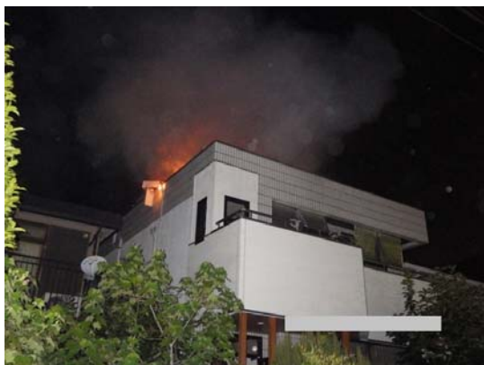
写真 2-5-1 消防隊到着時の状況
