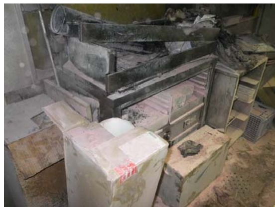
写真 8-4 電気魚焼器の焼損状況
