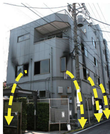
写真 6-9-3 飛び降り避難の状況
