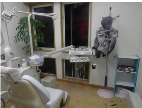
写真 6-5-3 出火室の状況
