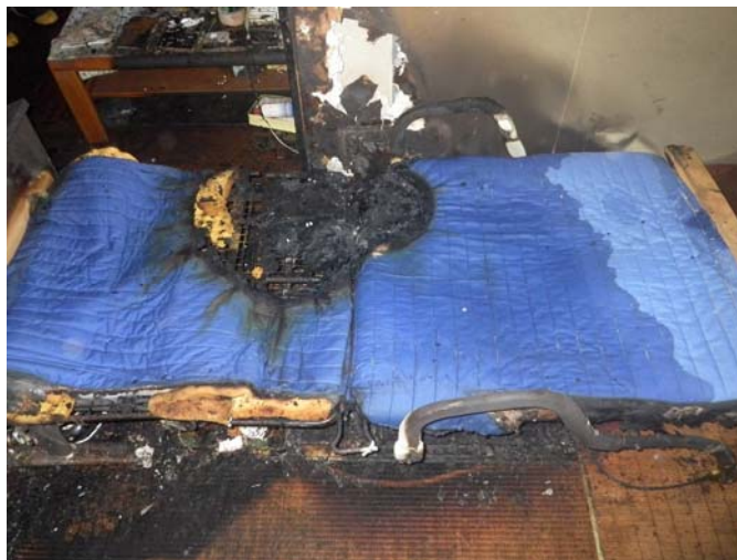
写真 2-2-2 ベッドの焼け込みの状況
