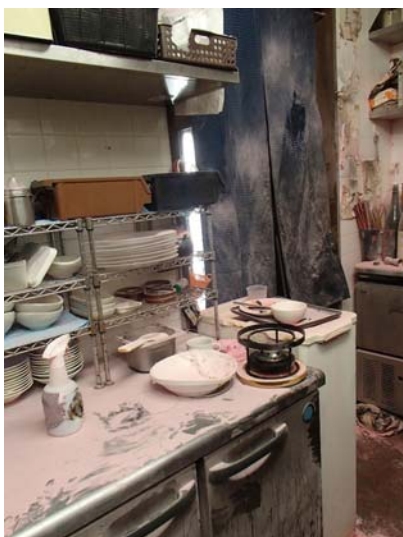
写真 2-8-1 アルコールポットの状況
