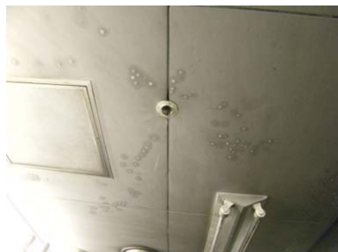
写真 7-5 作動したスプリンクラー
