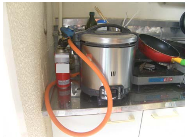
写真 3-3-3 ガス炊飯器とボンベの状況
