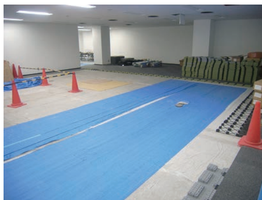
写真 5-2-1 内装工事の状況
