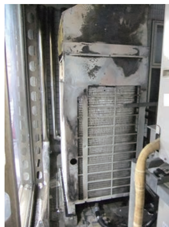
写真 7-1 室外機の状況
