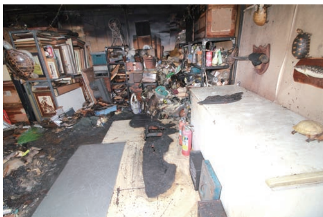
写真 6-8-1 倉庫内の状況
