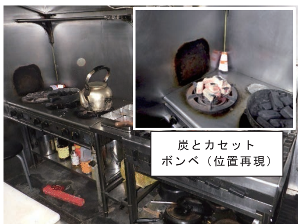
写真 3-4-1 大型ガスこんろ周辺の状況
