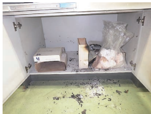
写真 6-6-2 実験台下部の状況
