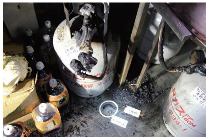
写真 2-7-2 プロパンガス付近の状況
