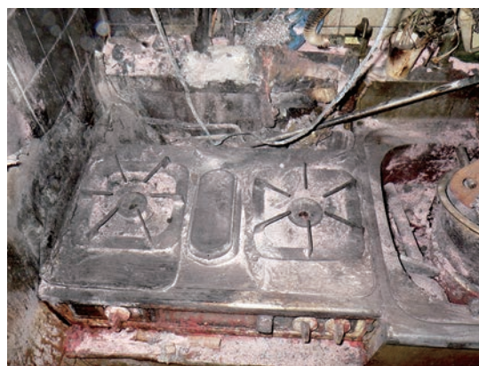
写真 3-1-2 ガステーブルの焼損状況
