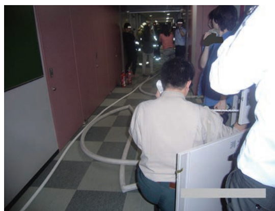
写真 7-2 補助散水栓の使用状況
