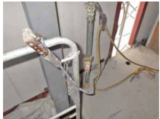
写真 18-1 使用した電気溶接器の状況
