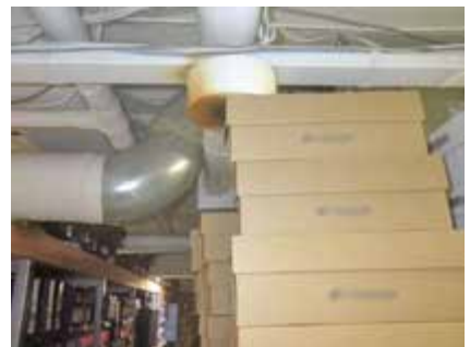
写真 21-6 復元した状況
