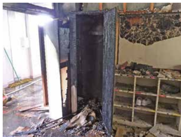
写真 24-5 ロッカーの状況
