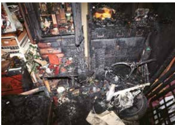
写真 5-1 テーブル付近の状況
