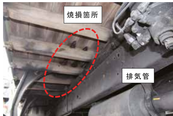
写真 30-1 荷台下部の焼損状況
