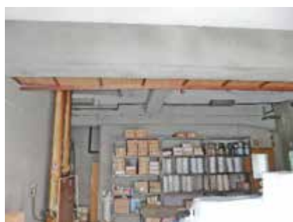
写真 26-1 倉庫内の状況
