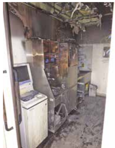
写真 32-1 処理室の状況
