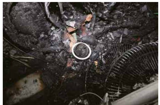
写真 5-2 燭台の受け皿部分の状況
