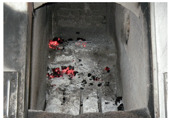
写真 25-2 焼却炉内の状況
