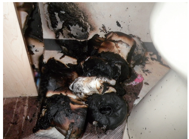
写真 4-4 焼損した収容物の状況
