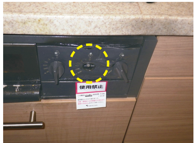
写真 7-2 ガステーブルの焼損状況 （黄色枠は、炎が出たスイッチ部）
