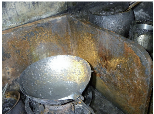
写真 9-2 大型ガスこんろ上の状況
