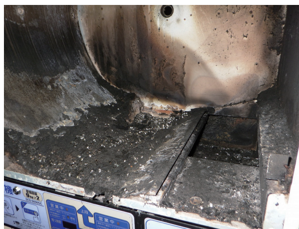
写真 7-4 堆積していた埃の焼損状況
