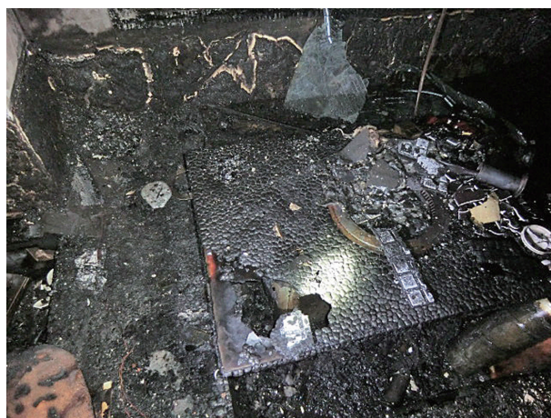
写真 20-4 焼損した客席状況
