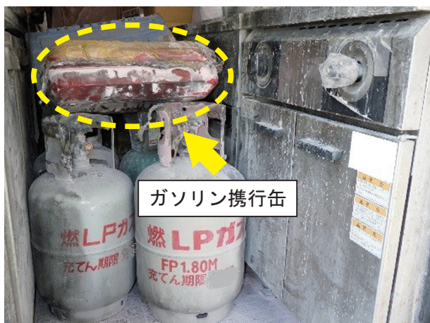
写真 10-3 調理室内の焼損状況
