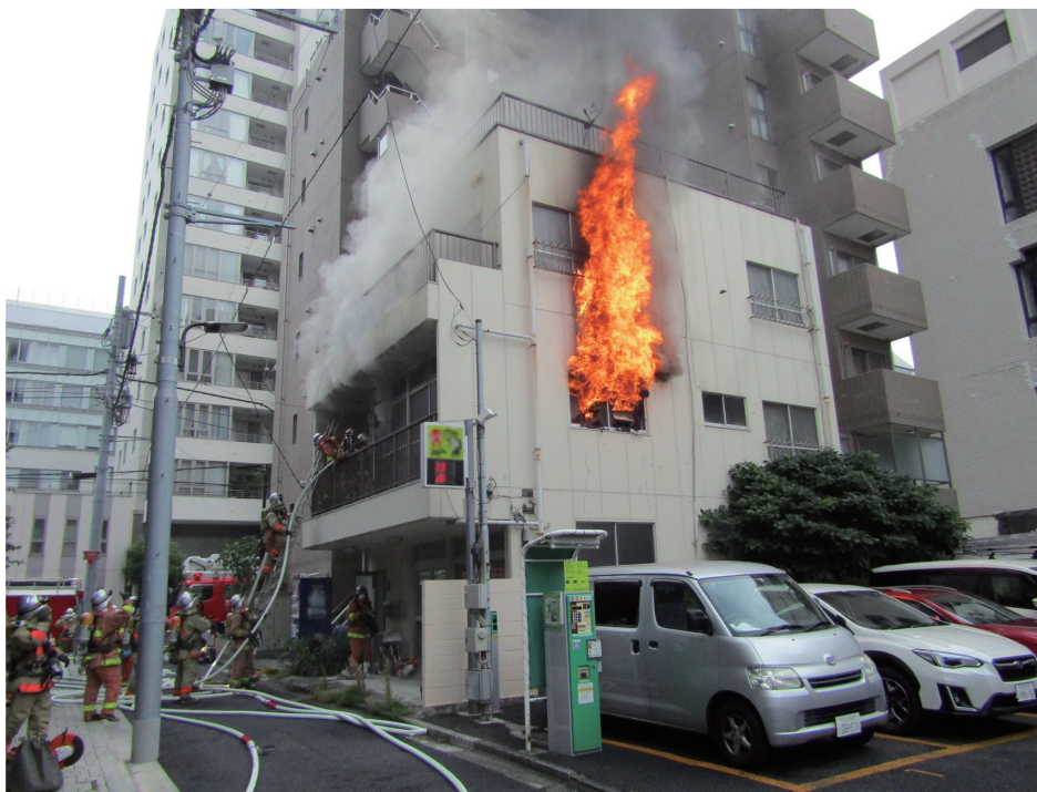
2 階居室から出火した火災
