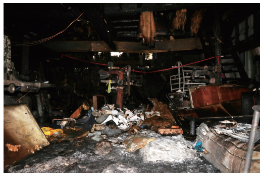
写真 14-3 作業場の状況
