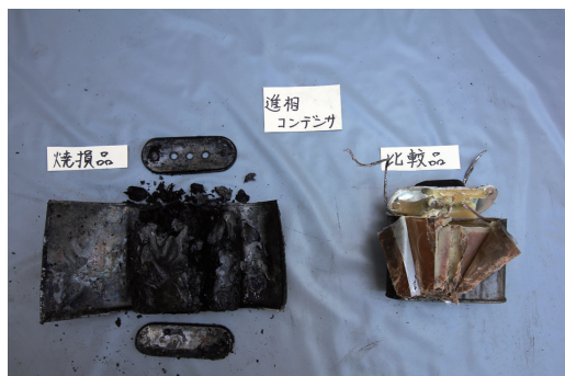
写真 14-5 焼損した低圧進相コンデンサの状況
