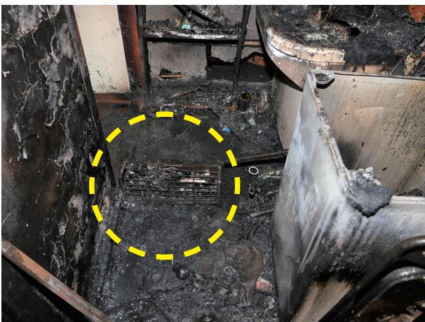
写真 14-1 脱衣場の状況
