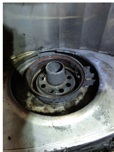
写真 8-2 芯付近の焼損状況
