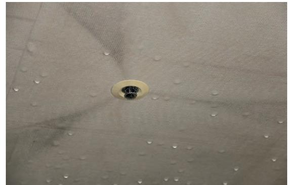
写真 31-2 スプリンクラーの作動状況
