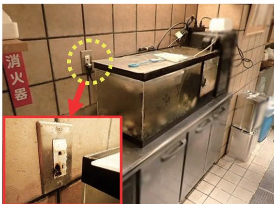
写真 6-1 壁付コンセント周辺の焼損状況
