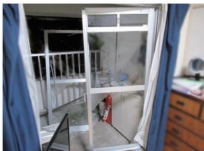
写真 12-2 サッシの破損状況
