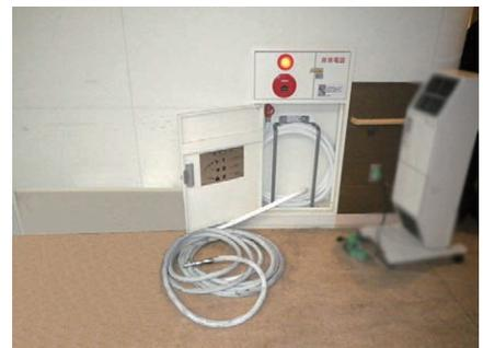
写真 32-2 補助散水栓の状況
