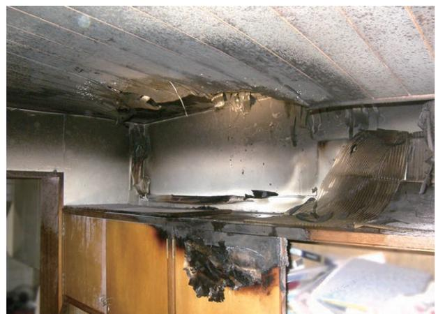
写真 12-6 天井の焼損状況
