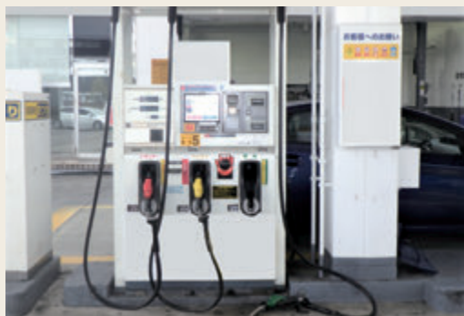
▲事故の発生した固定給油設備の状況（軽油のノズルが落下している）
