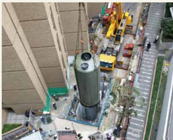
▲ 危険物タンクの設置時の状況
