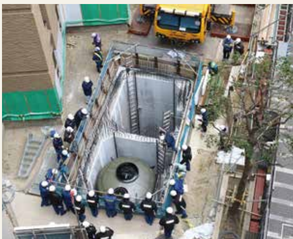
▲ 危険物タンクの設置時の状況
