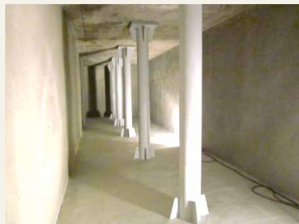
▲ 経年防火水槽の再生
