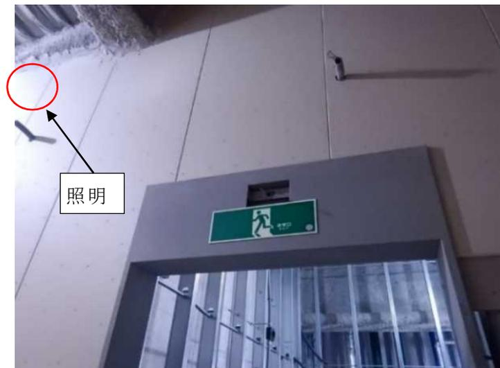
図3-12 避難口誘導標識及び近傍に設置した照明
