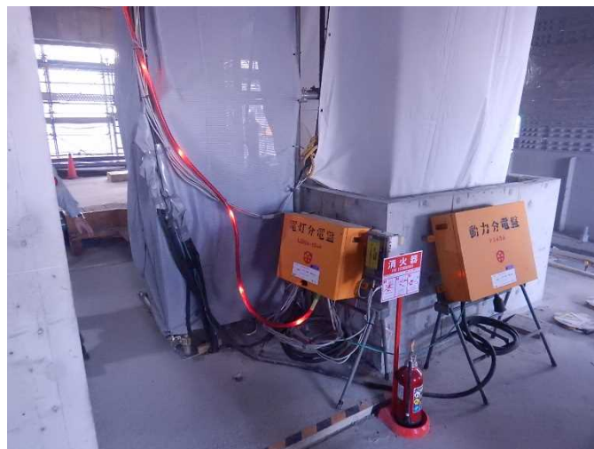
図 3 - 4 避難経路への赤色 LED チューブ設置例
