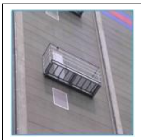
写真7-1 非常用進入口
