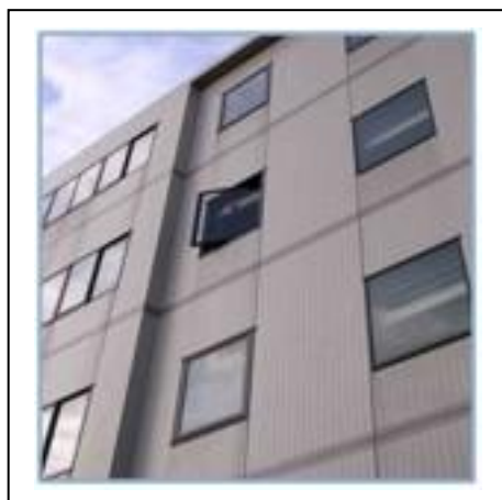
写真7－2 非常用進入口（代替開口部）
