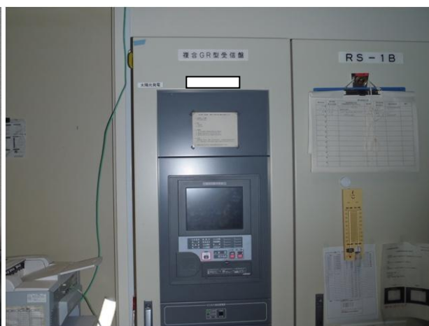
写真 7-15 自動火災報知設備受信機の例
