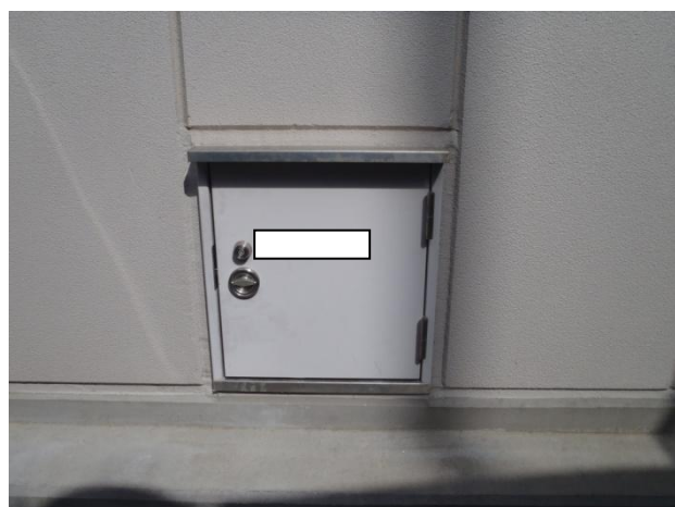
写真 7-14 ハト小屋点検口の例
