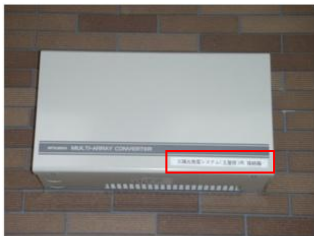
写真 7-4 屋外用パワコンの例
