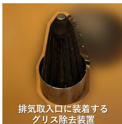
写真 2 - 10 グリス除去装置
