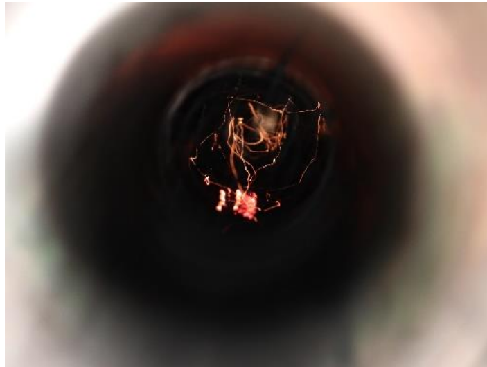
写真 5－11 ダクト内部に着火した状況（着火有）
