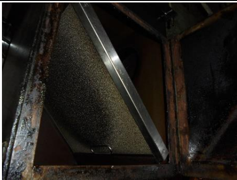
写真 5-18 店舗 F グリスフィルター
