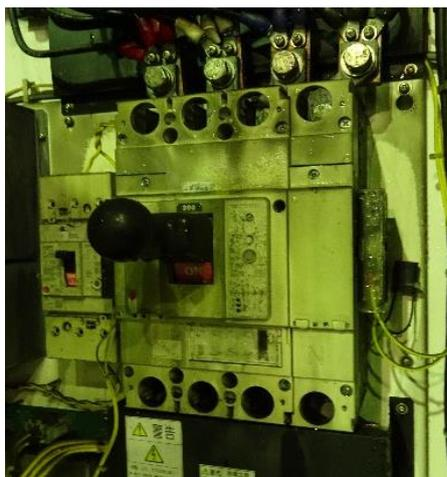
写真 6-10 漏電遮断器(100mA、0.1 秒)の作動状況
