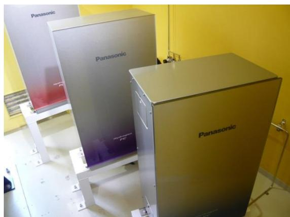
図 3.1.2-6 山梨県米倉山太陽光発電所の 700W 純水素燃料電池 (3 台)
