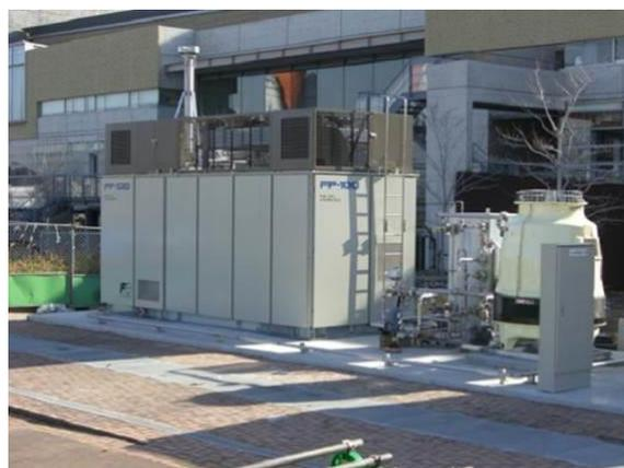
図 3.1.2-3 北九州水素タウン設置の 100kW 純水素燃料電池（りん酸形）
