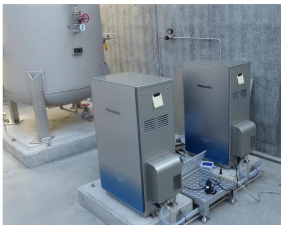
図 3.1.2-7 水素ステーション静岡の 700W 純水素燃料電池 (2 台)
