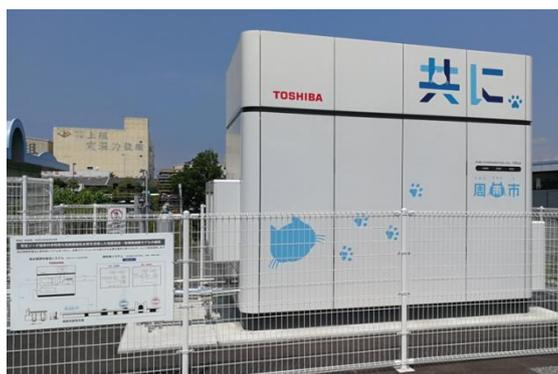
図 3.1.2-5 山口県周南市で稼働中の 100kW 純水素燃料電池
