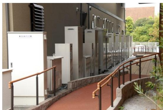
図 3.1.2-4 北九州水素タウン設置の 700W 純水素燃料電池
