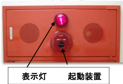
《消火栓箱上部》
