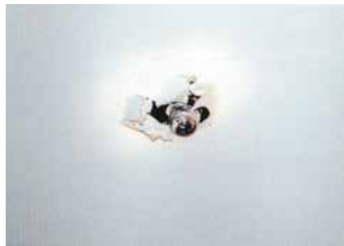
スプリンクラー設備の被害例
