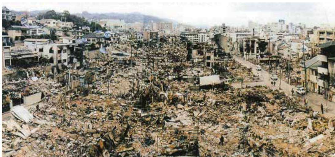
広範囲に焼失した街区を高所から撮影した写真
