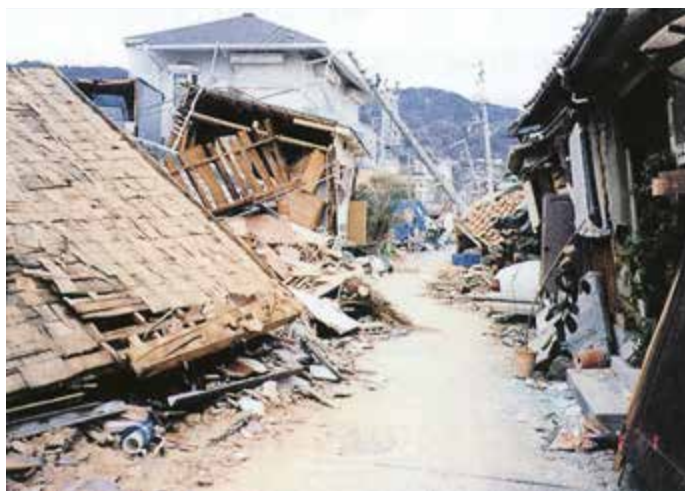
完全に潰れた木造建物（阪神・淡路大震災）
