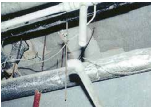
スプリンクラー設備の被害例
