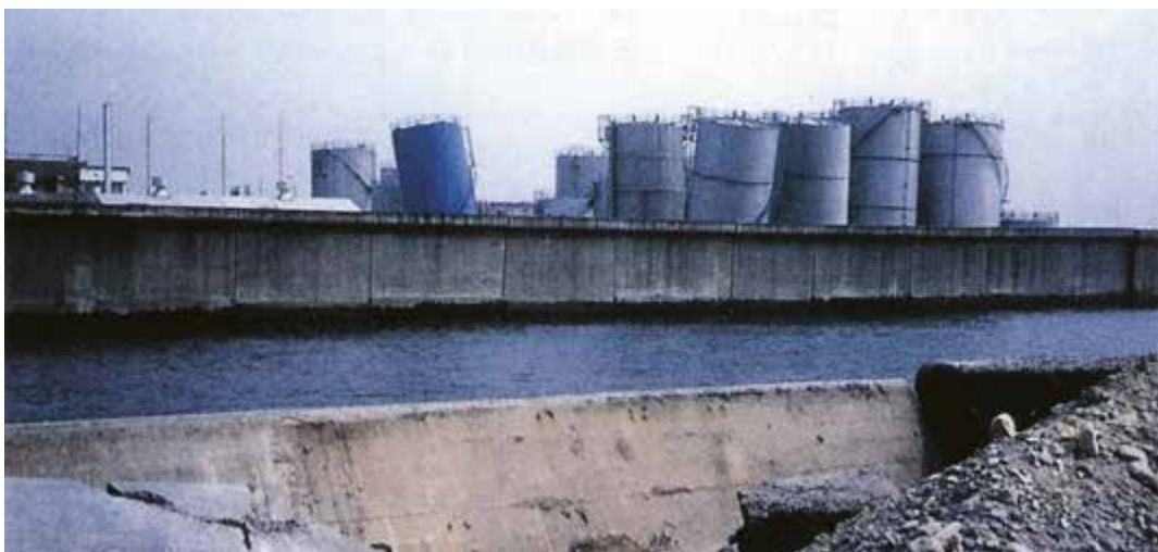
傾斜したタンク群
