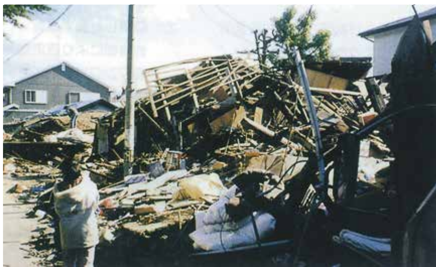
震災後の建物の状況
