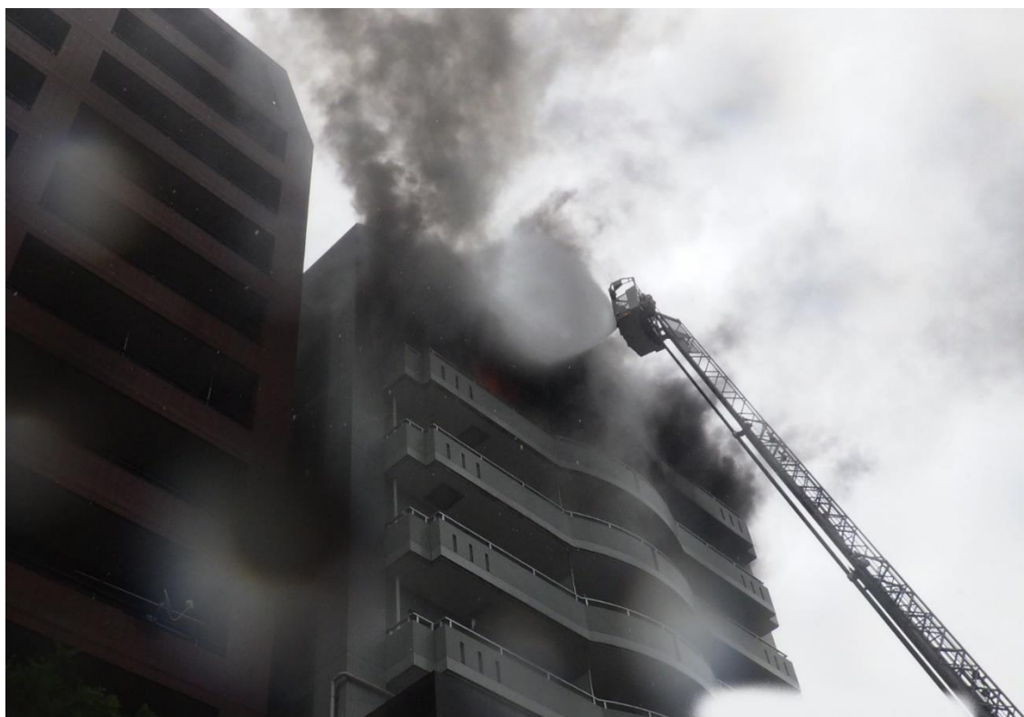
④共同住宅8階の延焼状況（6月）
