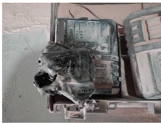
写真 16-2 出火したバッテリーの状況
