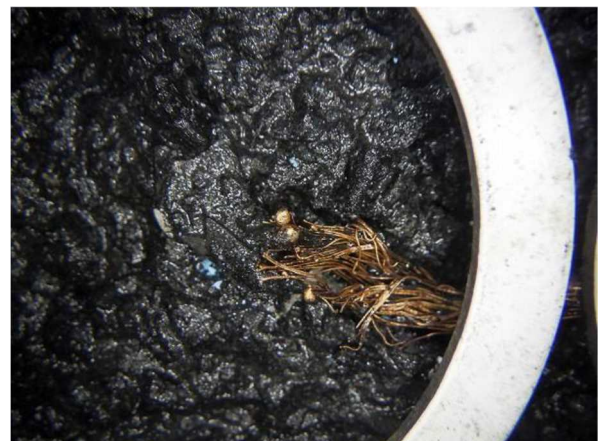
写真 25-2 焼損したコードの短絡状況
