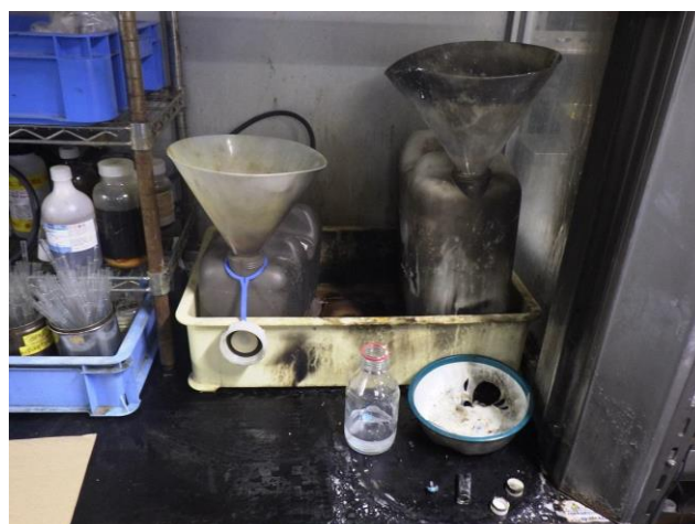
写真 23-4 焼損した廃液タンクの状況
