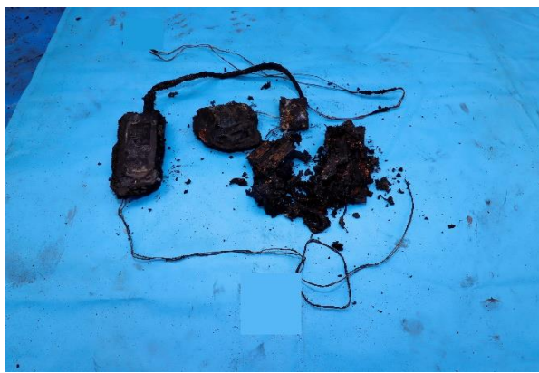
写真 6-4 バッテリーの焼損状況
