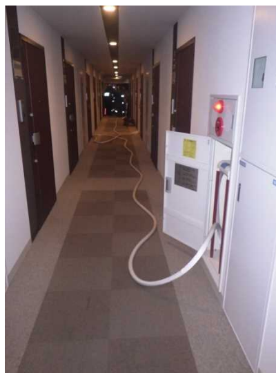
写真 30-5 延長した屋内消火栓設備の状況
