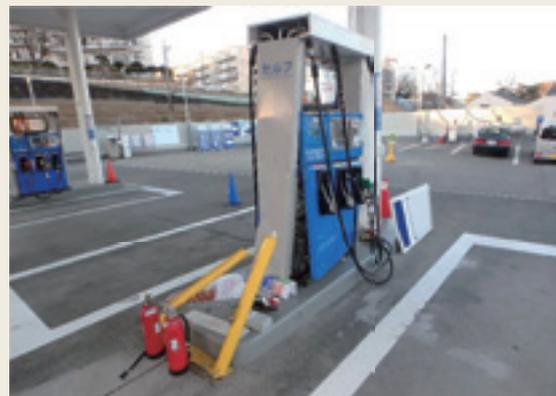
▲ 固定給油設備の破損状況
