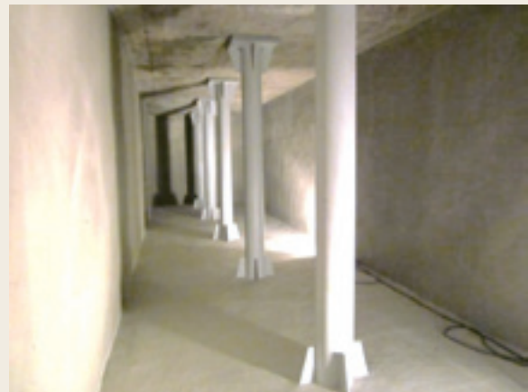
▲ 経年防火水槽の再生
