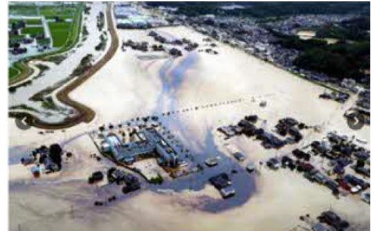
写真① 鉄工所の油流出事故の状況
