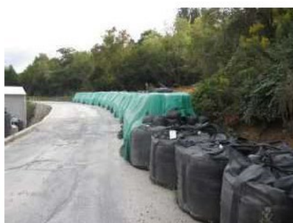
敷地境界に土嚢を設置
