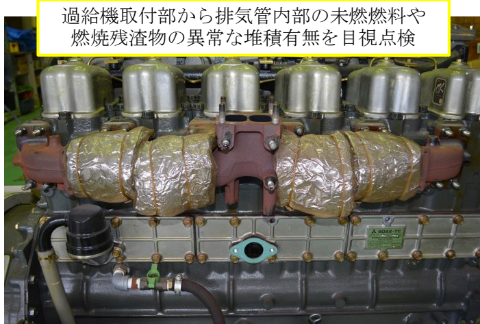
図2 排気管内部目視点検
