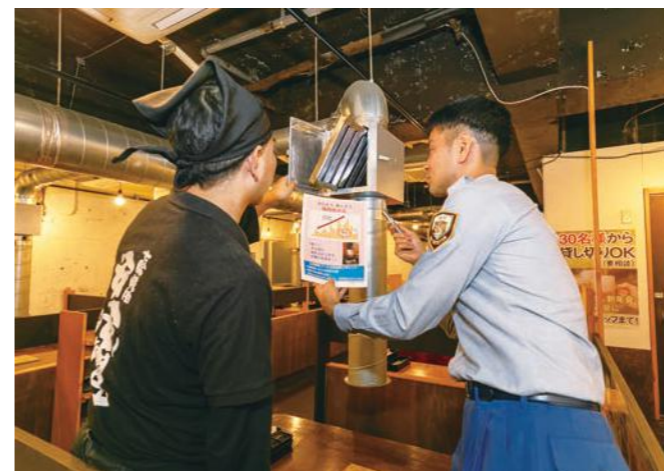
▲飲食店従業員にダクト汚れの危険性を指導
