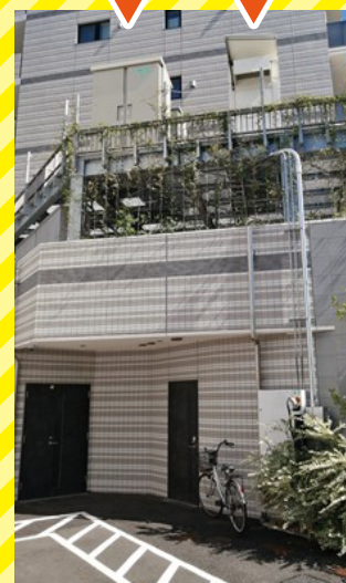
浸水に備えた設置状況
