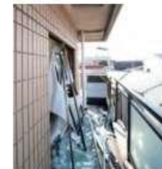
室内でストーブが原因となりスプレー缶内のガスに引火し爆発した火災（屋外ベランダの様子）
