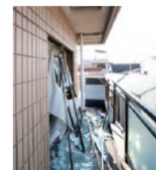
室内でストーブが原因となりスプレー缶内のガスに引火し爆発した火災（屋外ベランダの様子）
