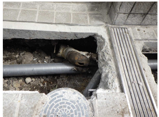
埋設配管の設置状況
