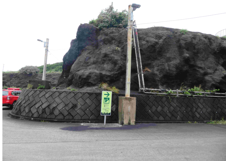
配管の敷設状況
