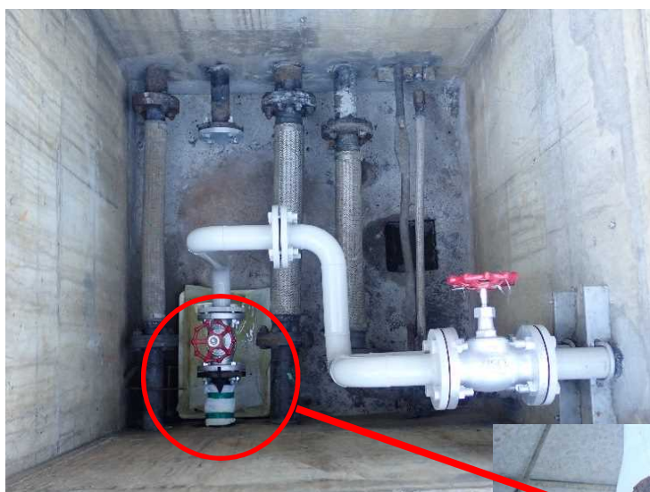
マンホール内の状況
