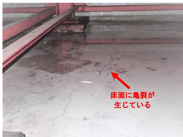
タンク室床面の亀裂の状況
