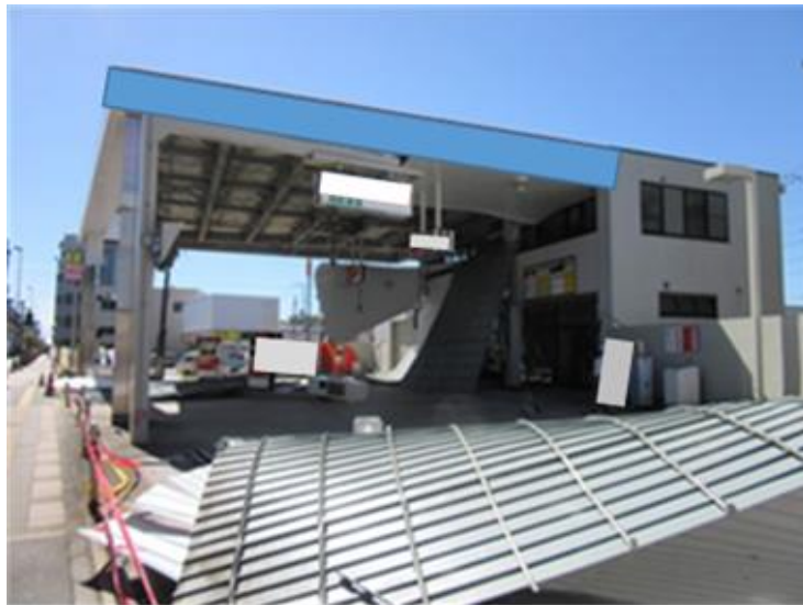
給油取扱所の状況
