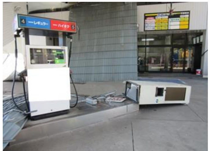
強風で転倒したPOS外設機
