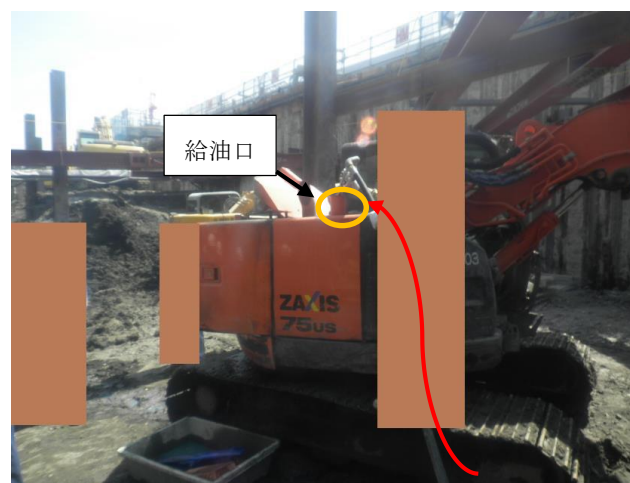
小型重機への給油状況
