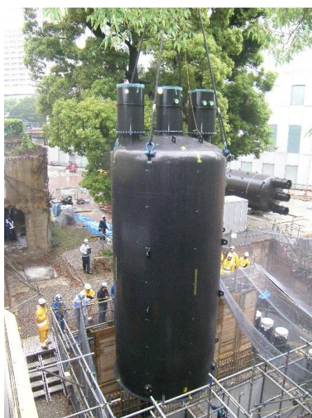
工事中の縦置円筒型地下タンク貯蔵所
