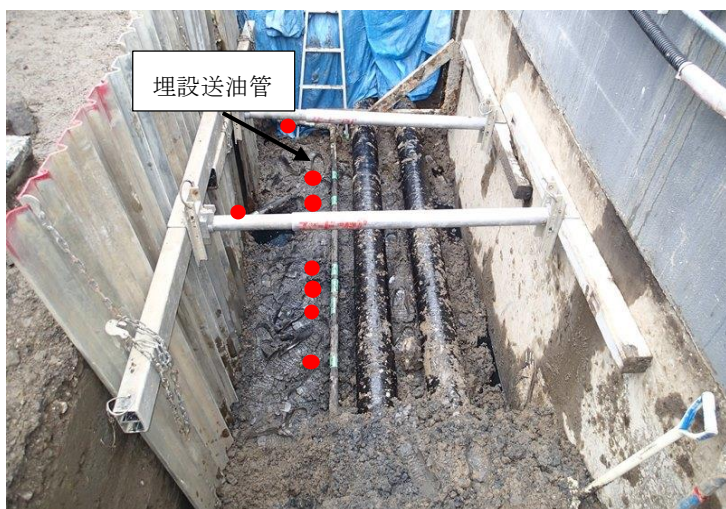
埋設配管掘削時の状況（●：開孔部の位置）
