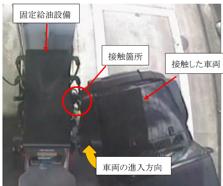
固定給油設備と車両の接触状況
