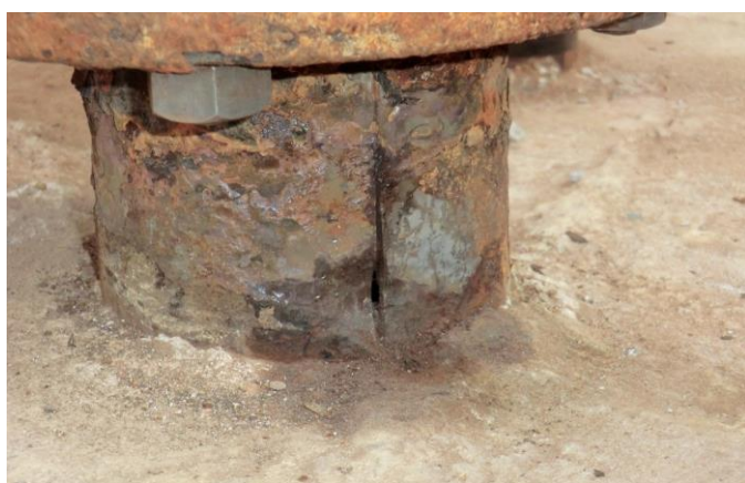
配管取付け部分の開孔状況
