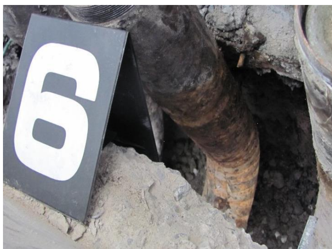
掘削作業時の状況
