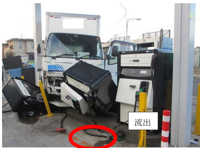
給油ノズルからの流出状況
