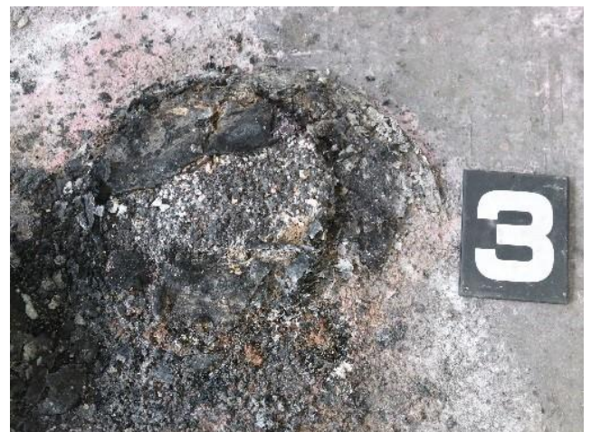
出火したポリバケツの焼損状況
