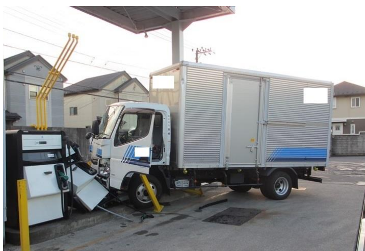
2 t トラックが固定給油設備に衝突した状況
