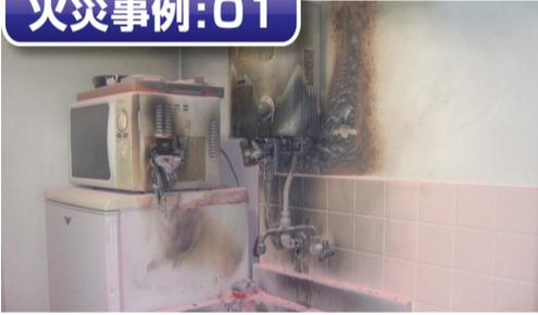
廃棄のため、台所の流し台で中身が残っているエアゾール缶に穴をあけたところ、使用していた湯沸器の炎が、エアゾール缶から噴出した可燃性ガスに引火し出火した。
