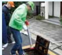
消火栓に差し込む
