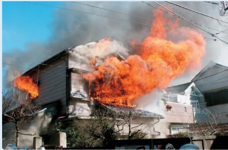
住宅火災写真（書籍「火災の実態」より）
