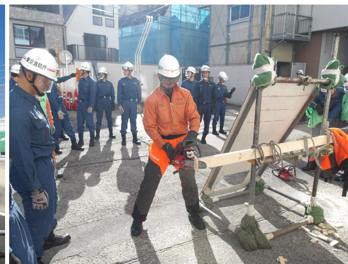
倒壊家屋内へチェーンソーを活用して内部進入
