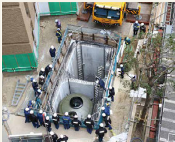
▲ 危険物タンクの設置時の状況
