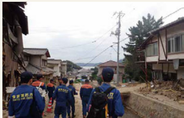
▲ 平成30年7月豪雨における現地調査
