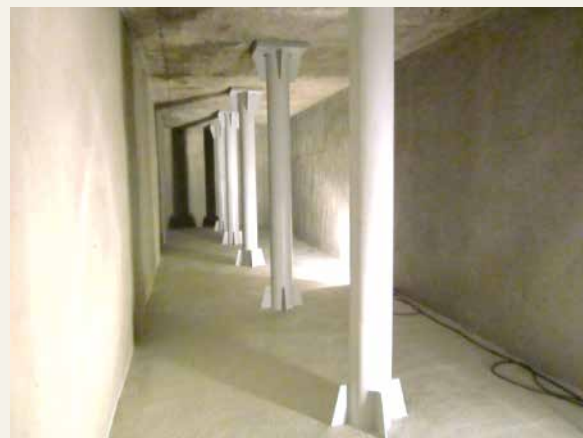
▲ 経年防火水槽の再生
